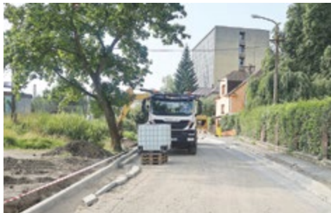
Oprava chodníků a veřejného osvětlení ulice Kubelkova
