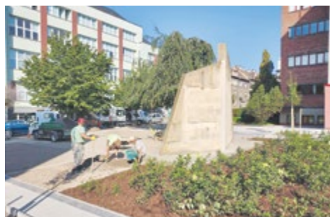
Rekonstrukce nástupního prostoru před ZŠ Habrmanova
