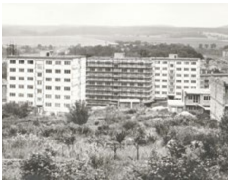
Pohled z Jelenice na domy před stavbou trafostanice
