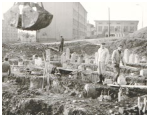
Po pilotáži základů domu č.p.1797
