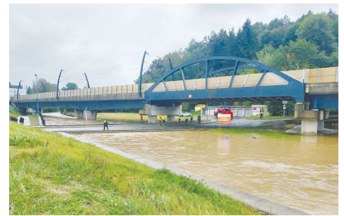
V nedalekém Ústí nad Orlicí byla situace závažnější, v neděli Tichá Orlice začala kulminovat a začala tlačit Třebovkou dále od soutoku. Rezervy prázdných pytlů z České Třebové byly poskytnuty na stavbu hráze v Kerharticích.
