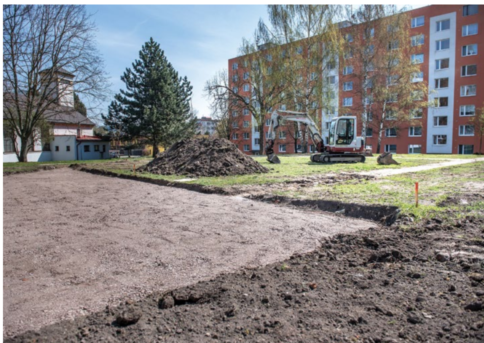
Výstavba nového dětského hřiště na sídlišti Trávník / foto: Michal Horák
