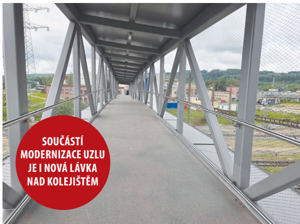
Modernizace železničního uzlu
